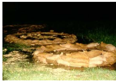
Konzentration von Erosionskanälen an Donaudeichen während des Hochwassers 1988 (Quelle: WWA Ingolstadt)
