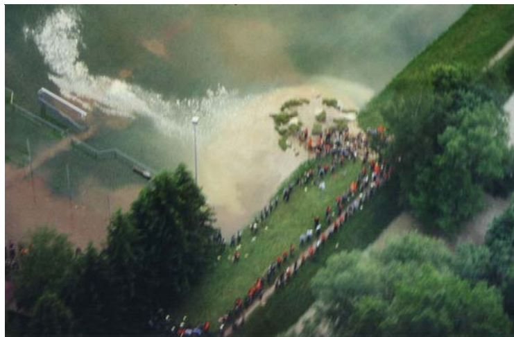
Abb. 7: Ausgewählte Schadensbeispiele (verschiedene Quellen)
